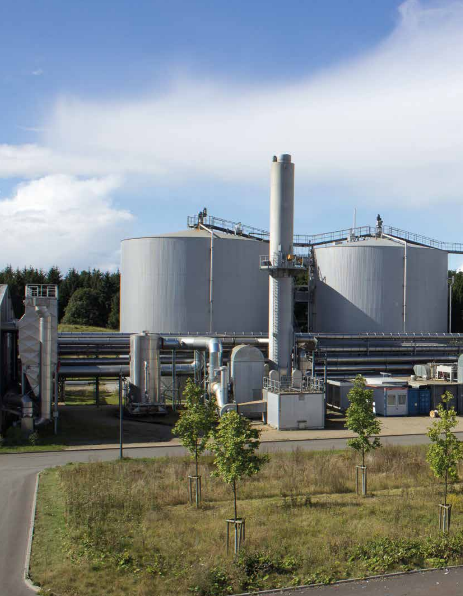
Die Mechanisch-biologische Abfallbehandlungsanlage der EBL. Hier wird aus Abfall Strom und Wärme gewonnen.
