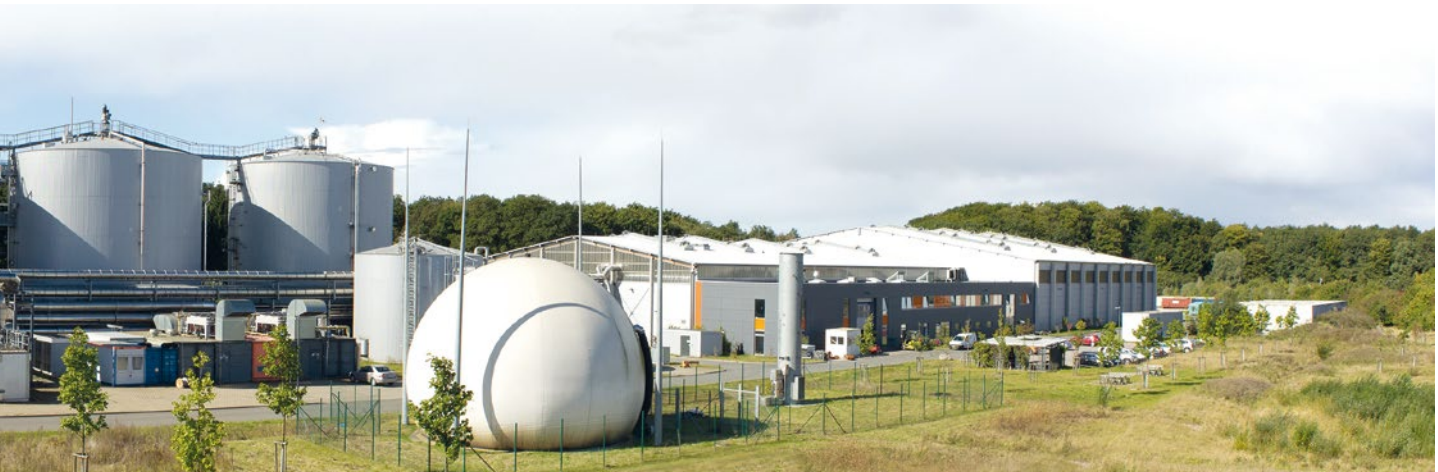
■ Die Lübecker Mechanisch-Biologische Abfallbehandlungsanlage (MBA) kann zukünftig noch effizienter betrieben werden. 5.000 Tonnen Bioabfälle aus dem Kreis Segeberg werden nun zusätzlich pro Jahr hier behandelt. Der Vertrag läuft zunächst bis 2020.
