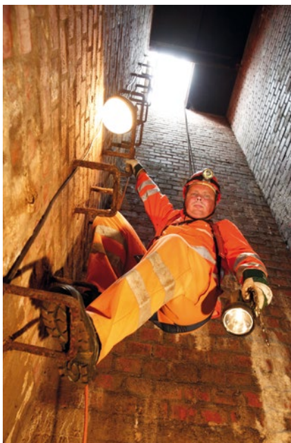
■ Während ein Mitarbeiter im Kanalschacht die nötigen Arbeiten verrichtet, muss ein Kollege oben für die ständige Sicherung sorgen.
